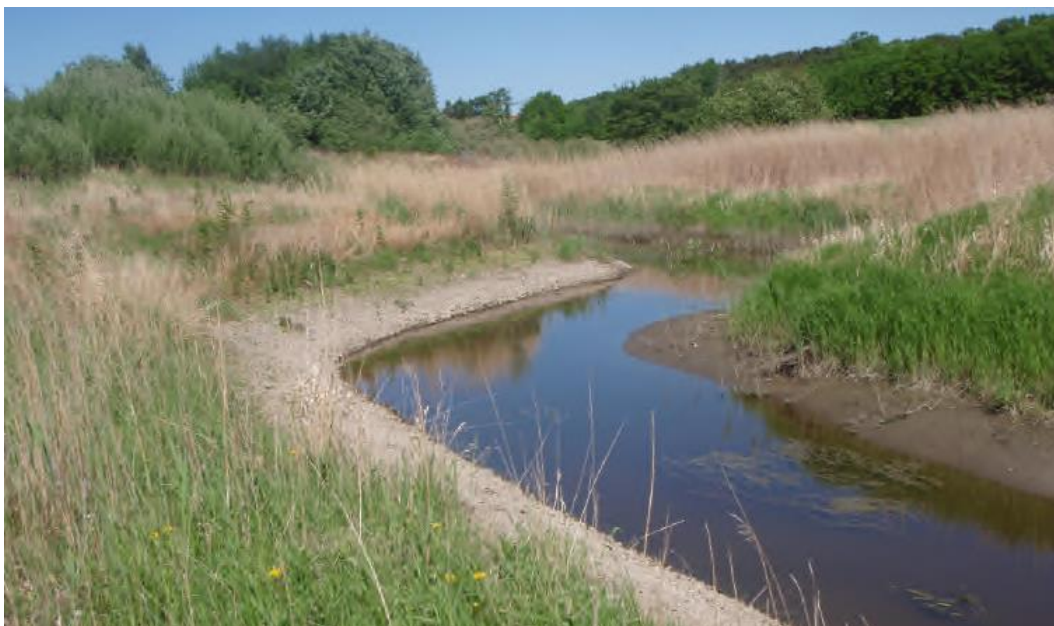
Figur 10 Lokalt, längst i öster, finns ett erosionsskydd längs den södra strandkanten.
